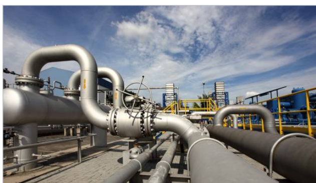
для монтажа трубопроводов
