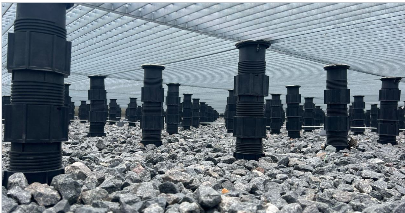
ОБЪЕКТ: Филиал Третьяковской галереи. Калининград. Регулируемые опоры HILST LIFT и Решетчатый настил HILST GRID PANEL.
