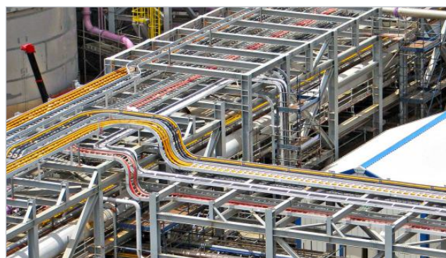
для монтажа кабельных трасс
