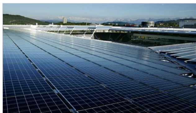
для монтажа солнечных батарей
