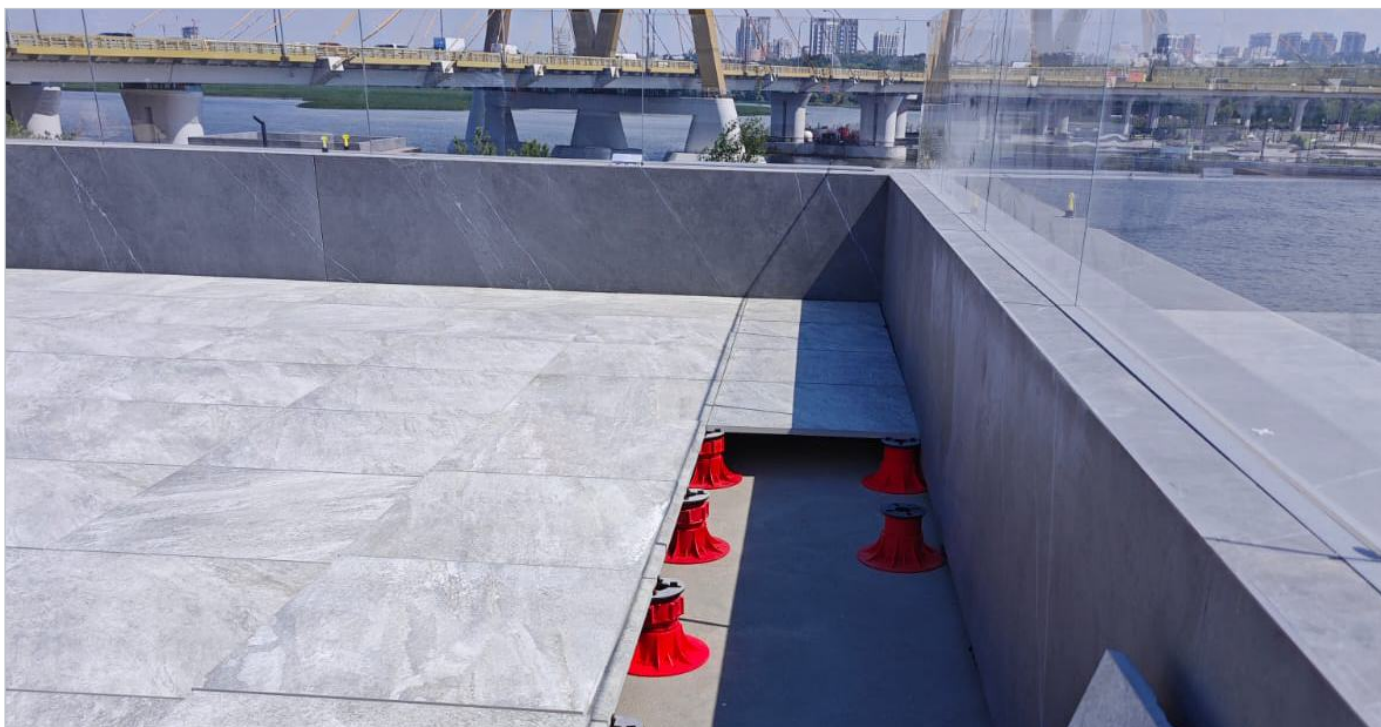
ОБЪЕКТ: Элитный жилой комплекс. Казань. Регулируемые опоры с повышенными характеристиками пожарной безопасности HILST LIFT F.
